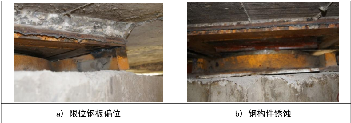
图 A.2 盆式橡胶支座病害
