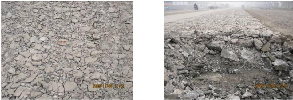
图3 多锤头碎石化比对板
