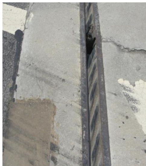
锚固混凝土开裂，橡胶止水带破损
