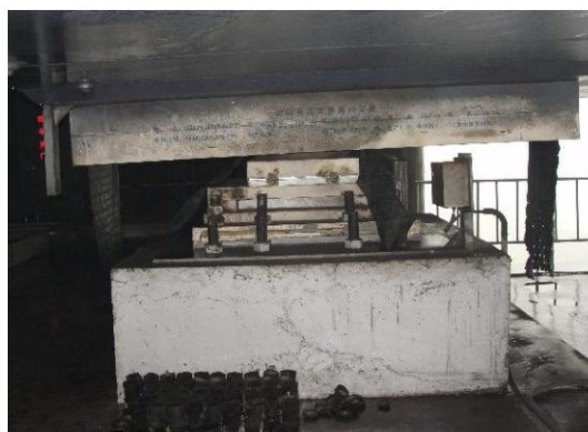
成堆更换下的剪切位移弹簧
