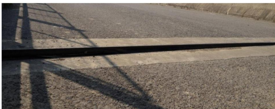
锚固混凝土开裂，橡胶止水带破损
