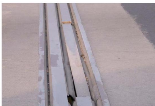
中梁钢断开掉落错位，中梁钢断开错位
