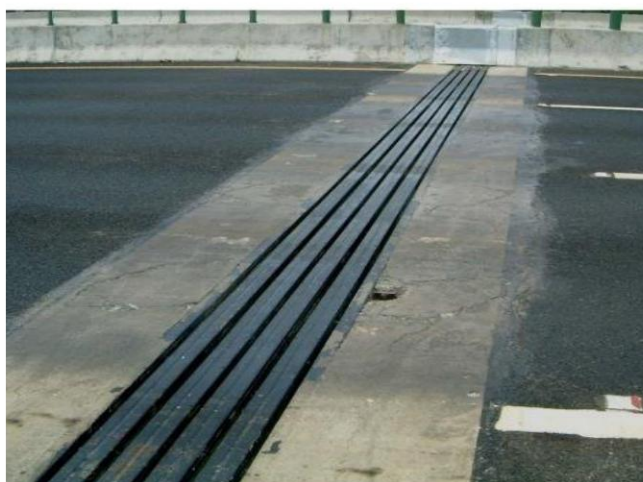
A.3 模数伸缩装置两边锚固混凝土开裂，破损
