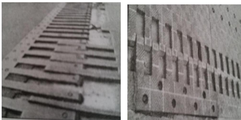
梳齿板伸缩装置锚固混凝土开裂破损
