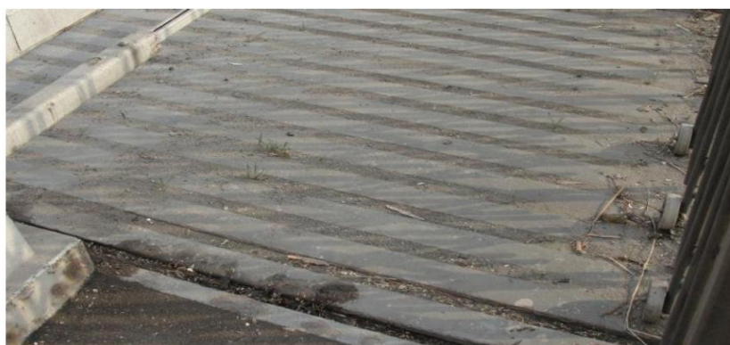
A.3 模数伸缩装置两边锚固混凝土开裂，破损
