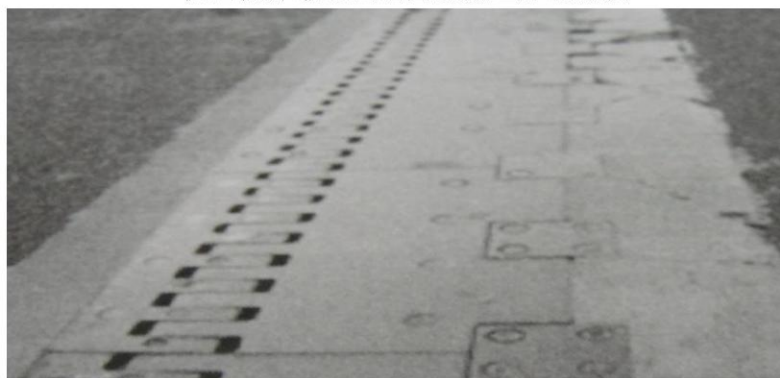
梳齿板伸缩装置锚固混凝土开裂破损
