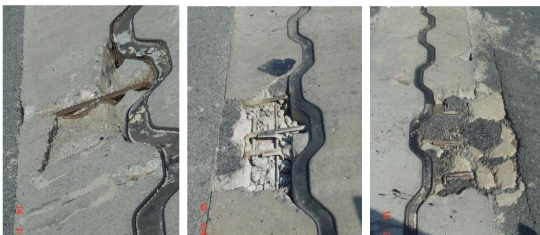
A.12 波形板伸缩装置专用胶老化失效与波形板脱开，锚固混凝土破裂损坏
