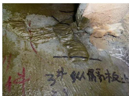
b) 加劲肋与隔板焊缝
