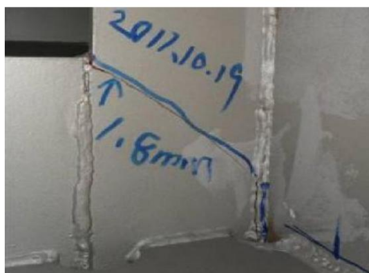
a) 竖向和纵向加劲肋焊缝
