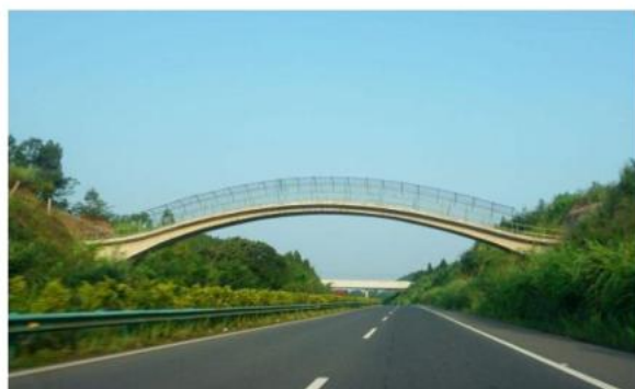
图 D.12 体量轻盈的高速公路上跨天桥
