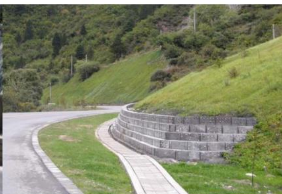
图 D.8 挡墙端部隐入边坡
