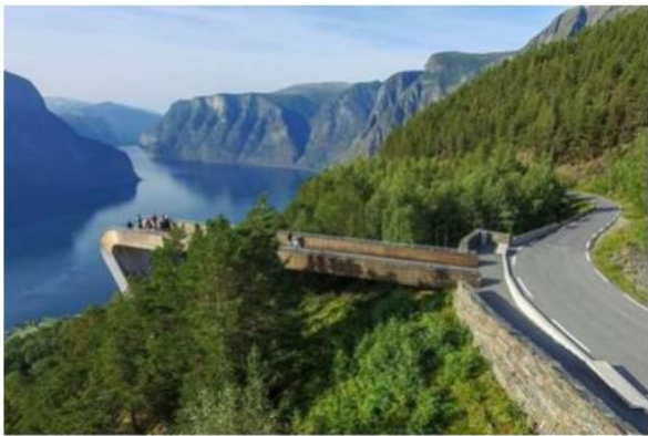
图 D. 23 公路观景台构筑物景观
