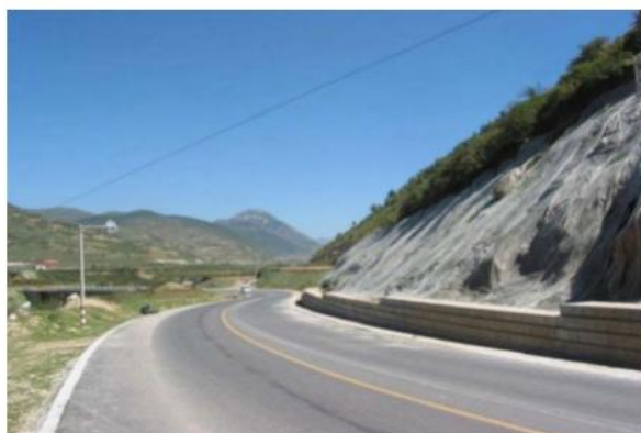
图 D.7 挡墙高度渐变
