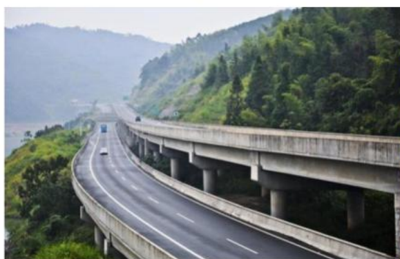
图 D.3 陡横坡路段采用上下分离路基减少景观影响
