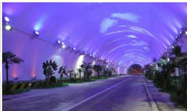
图 D. 15 高速公路隧道洞内景观装饰
