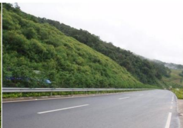
图 D.31 低矮灌木为主的高速公路边坡生态防护
