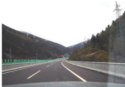
图 D.11 高速公路桥梁护栏有机硅涂装
