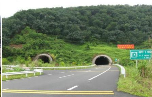
图 D. 41 生态恢复为主的高速公路隧道洞口
