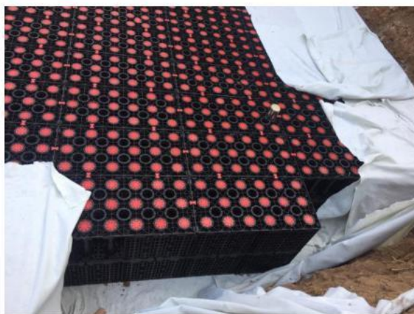
图 8 塑料模块组合水池安装
