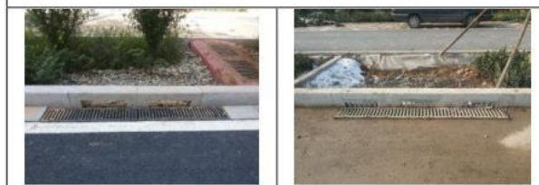
图3 进水口处收水、沉淀设施
