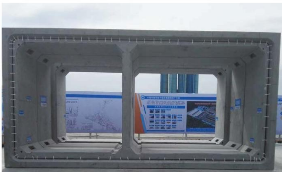
半整体预制拼装综合管廊
