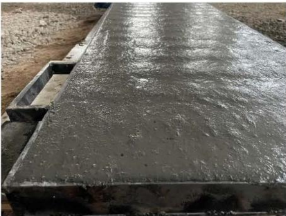
a) 钢桥面铺装坡度验证
