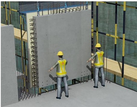
图 7.2.9 预制外墙吊装示意图
