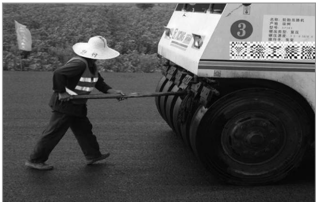
图G. 23 人工涂抹隔离剂
