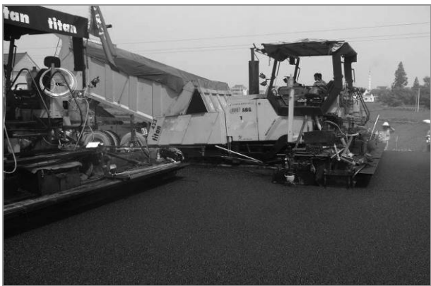
图G. 20 两台摊铺机间距应尽可能缩短
