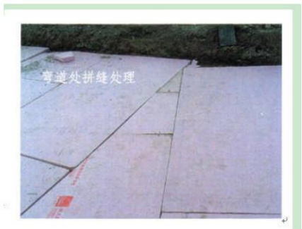
图A. 2 弯道处拼缝处理示意图
