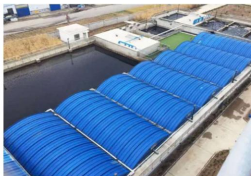
f) 厌氧污水池
