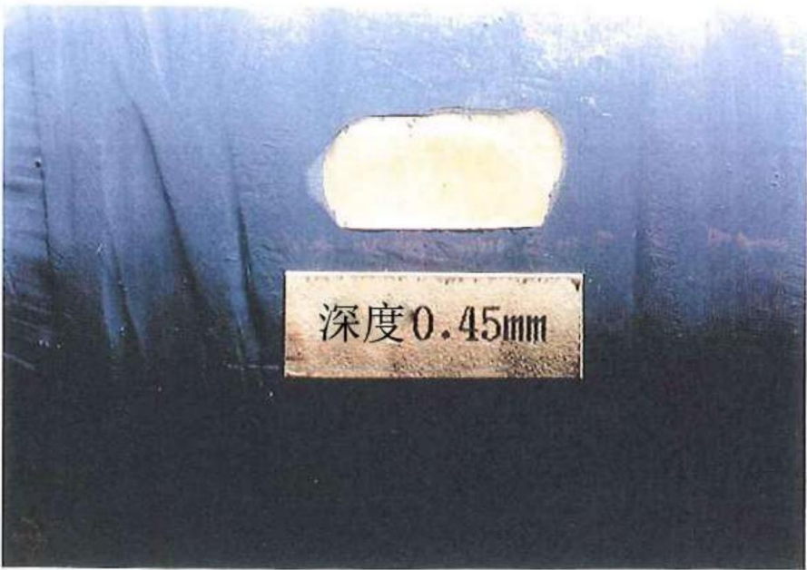
图 B. 3 二级损伤（可修复）
